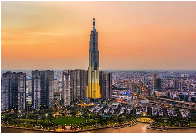
Dự án tòa nhà The Landmark 81
